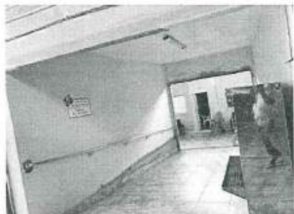
Foto 4: Corredor de Acesso
