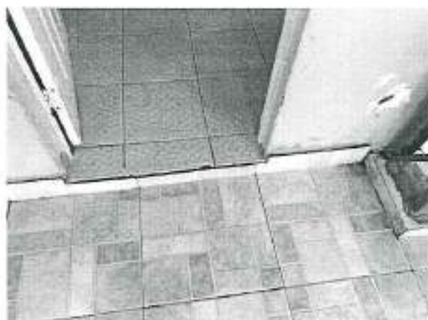
Foto 6: Porta de Acesso para o Quarto
